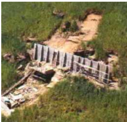
Figura 1: Muro com contraforte. Fonte: UERJ, online
